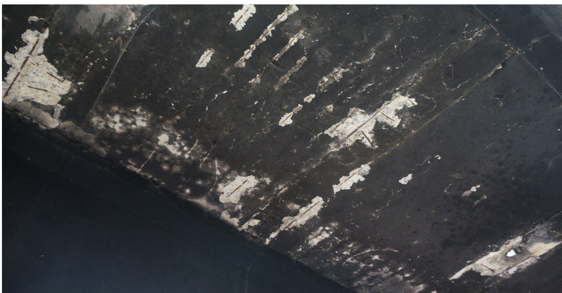
Foto 8 17/10/2017 Armadura exposta e corroída, segregação do concreto e manchas de fuligem atmosférica na face inferior das lajes
