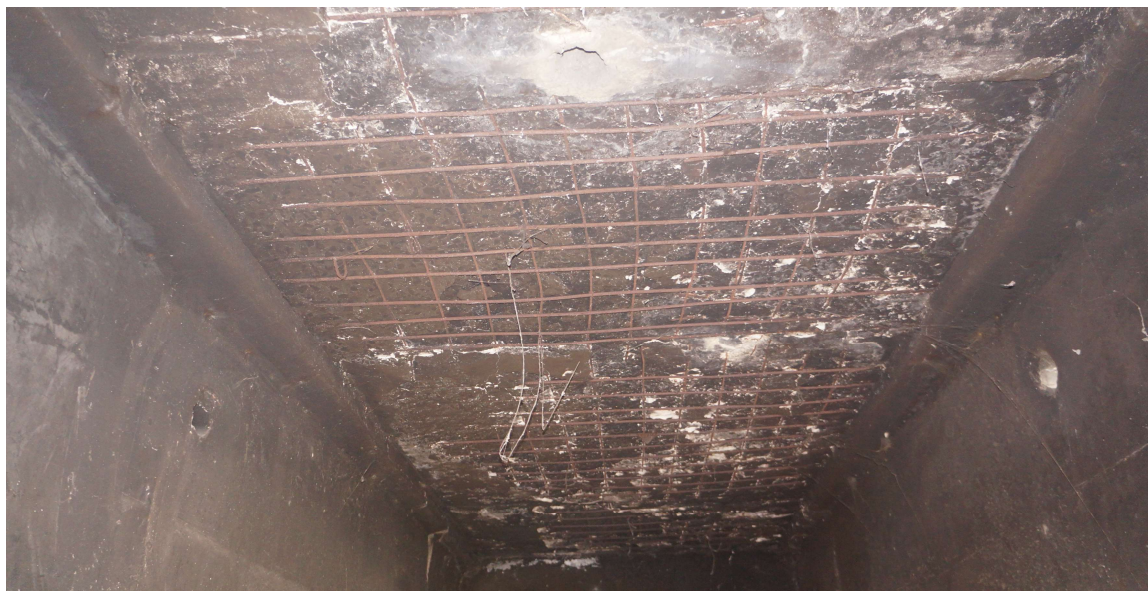
Foto 7 17/10/2017 Armadura exposta e corroída, segregação do concreto e manchas de fuligem atmosférica na face inferior das lajes. Problema generalizado.
